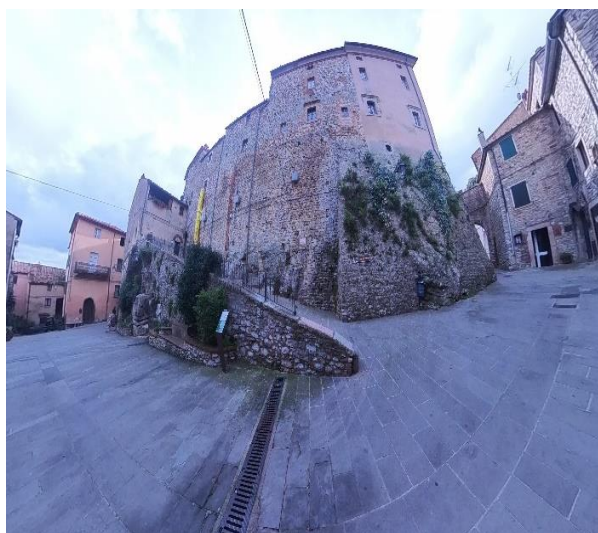
26 Rampa per raggiungere la Chiesa di S. Andrea
