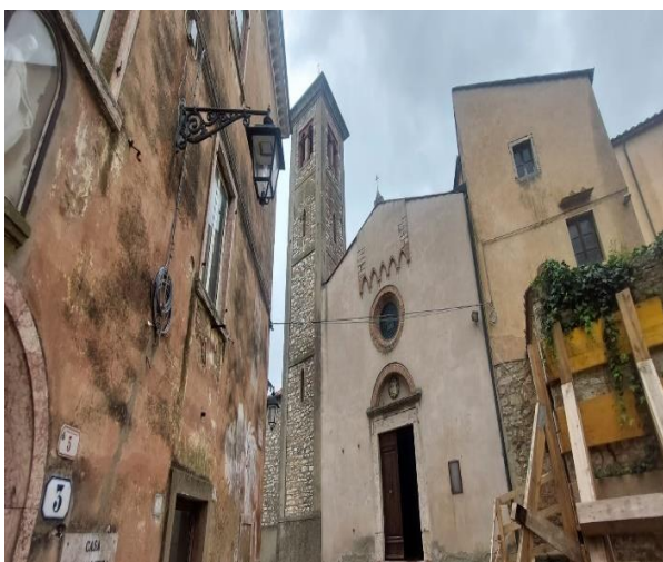
26 facciata e campanile
