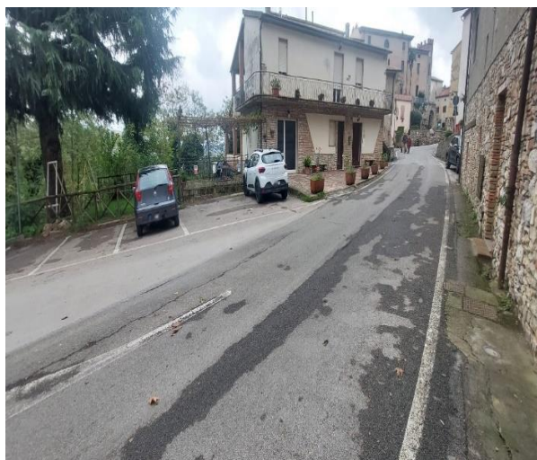
11 strada in asfalto
